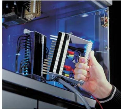
Bild 1. Prüfsteckvorrichtung Typ B14;
