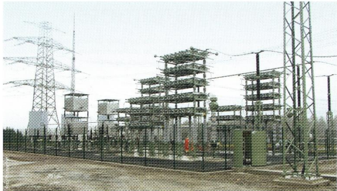
Im Umspannwerk Altenfeld wurde die erste Kondensatorbank zur Fingersung von Blindleistung im 50 Hertz-Netz errichtet.
